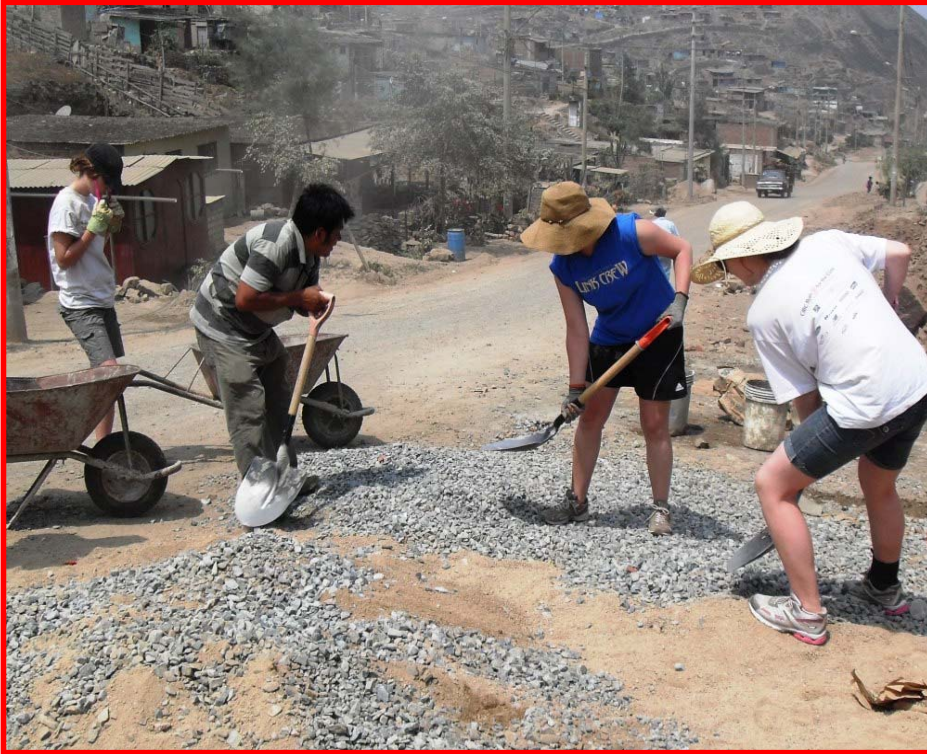
Preparando el material para la construcción de los servicios higiénicos, que beneficiara a 100 NNAs. (Aprox.)
